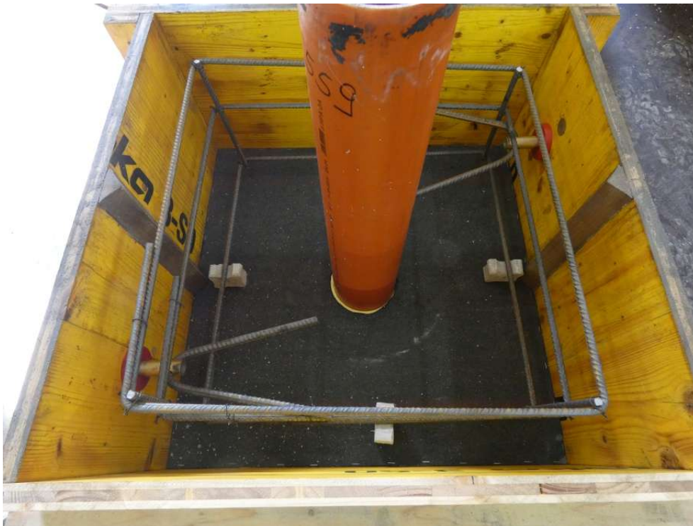
Bild 1 Prüfkörper in der Schalung vor der Betonage
